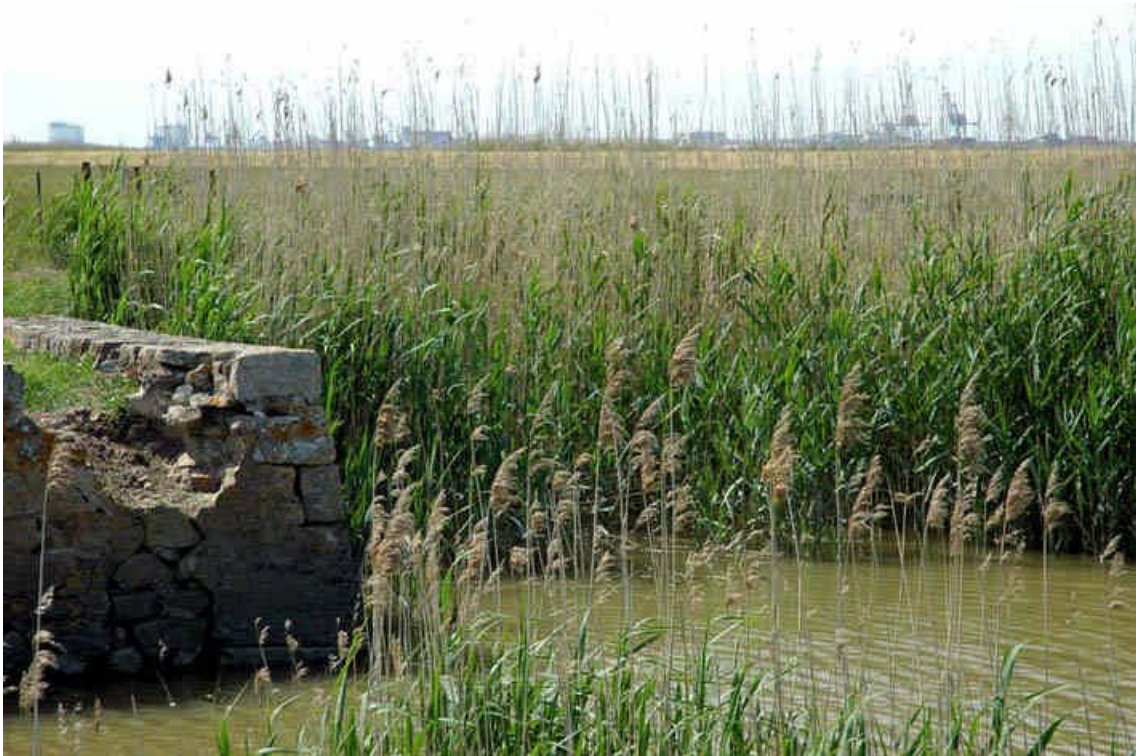
Partie du quai qui s'effondre. (cliché B. Cort Arce, ESTUARIUM, mai 2005)
