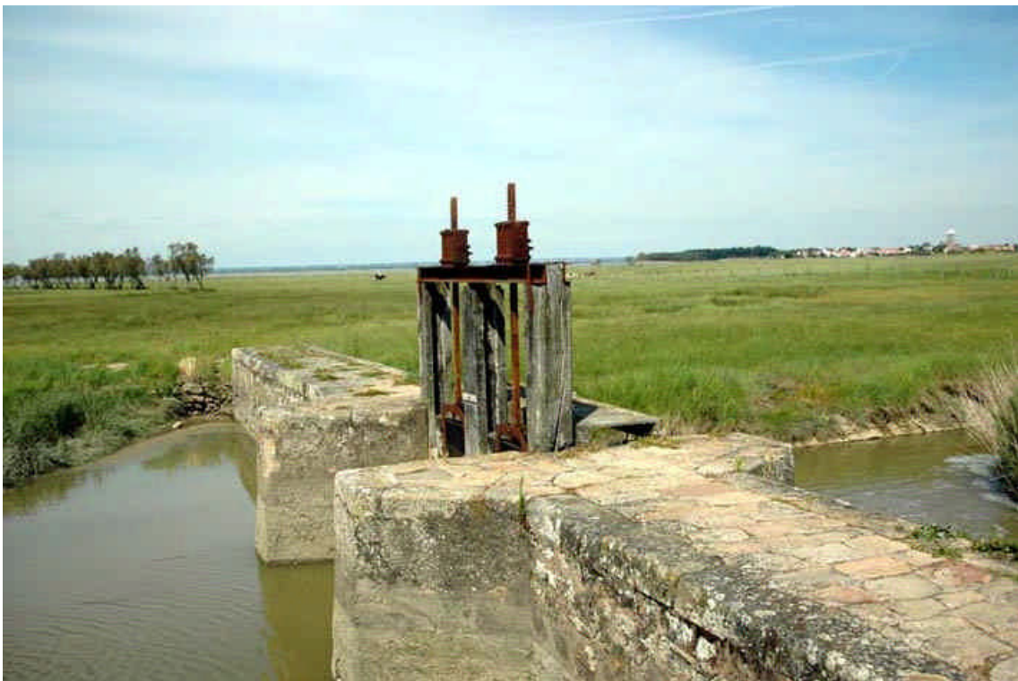
La vanne de chasse du port. (cliché B. Cort Arce, ESTUARIUM, mai 2005)
